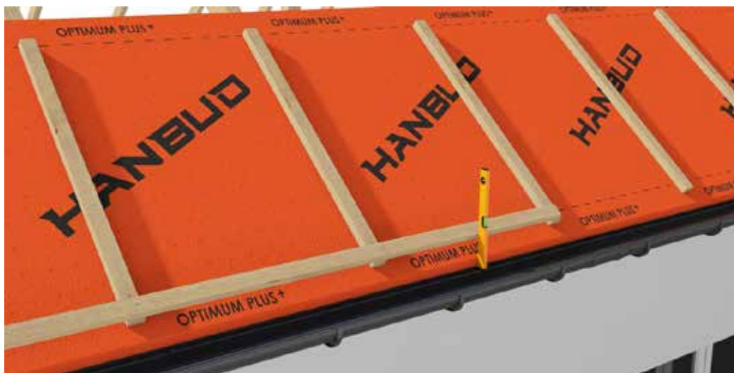
7. attēls Šķērslatu montāža uz jumta virsmas
