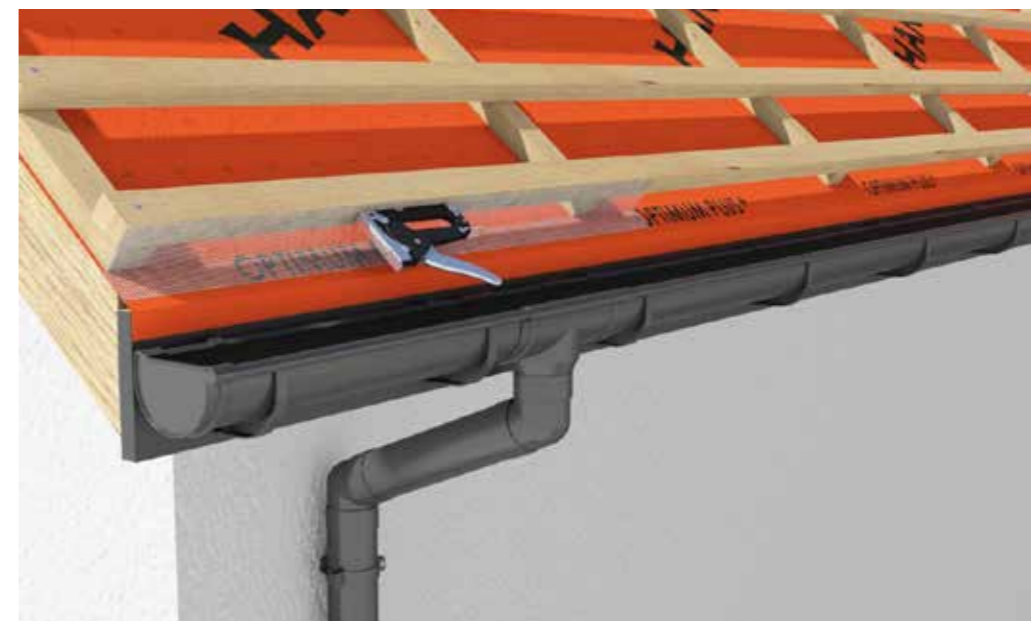
9. attēls Perforēta sieta uzstādīšana jumta karnīzes aizsardzībai pret kukaiņiem un gružiem.
