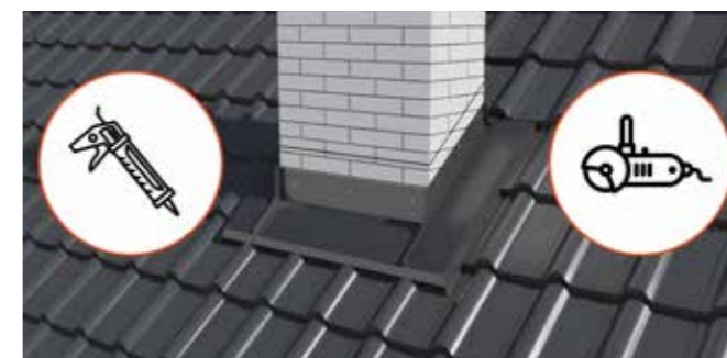
21. attēls Skursteņa iegriezums pirms augšējā elementa uzstādīšanas.
