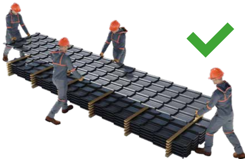
2. attēls Pareizs dakstiņveida paneļu transportēšanas veids.
